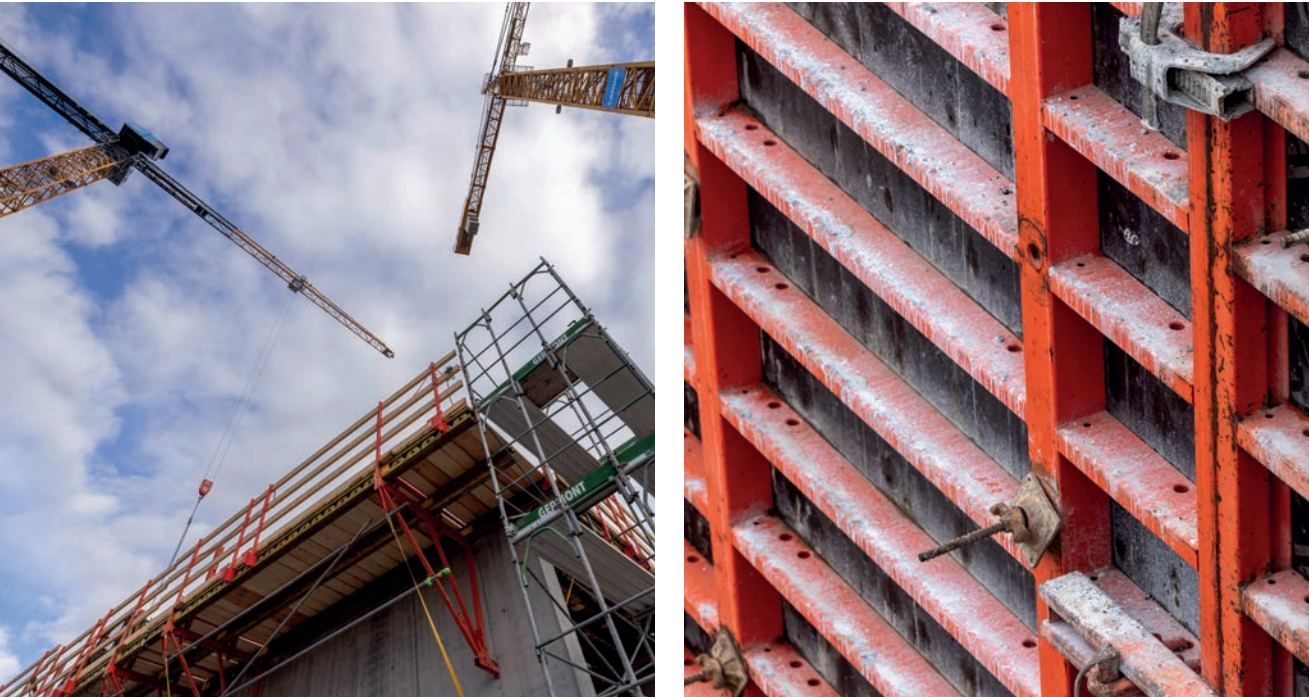
Sicherheit erfordert gerade auf Baustellen permanente Aufmerksamkeit.
