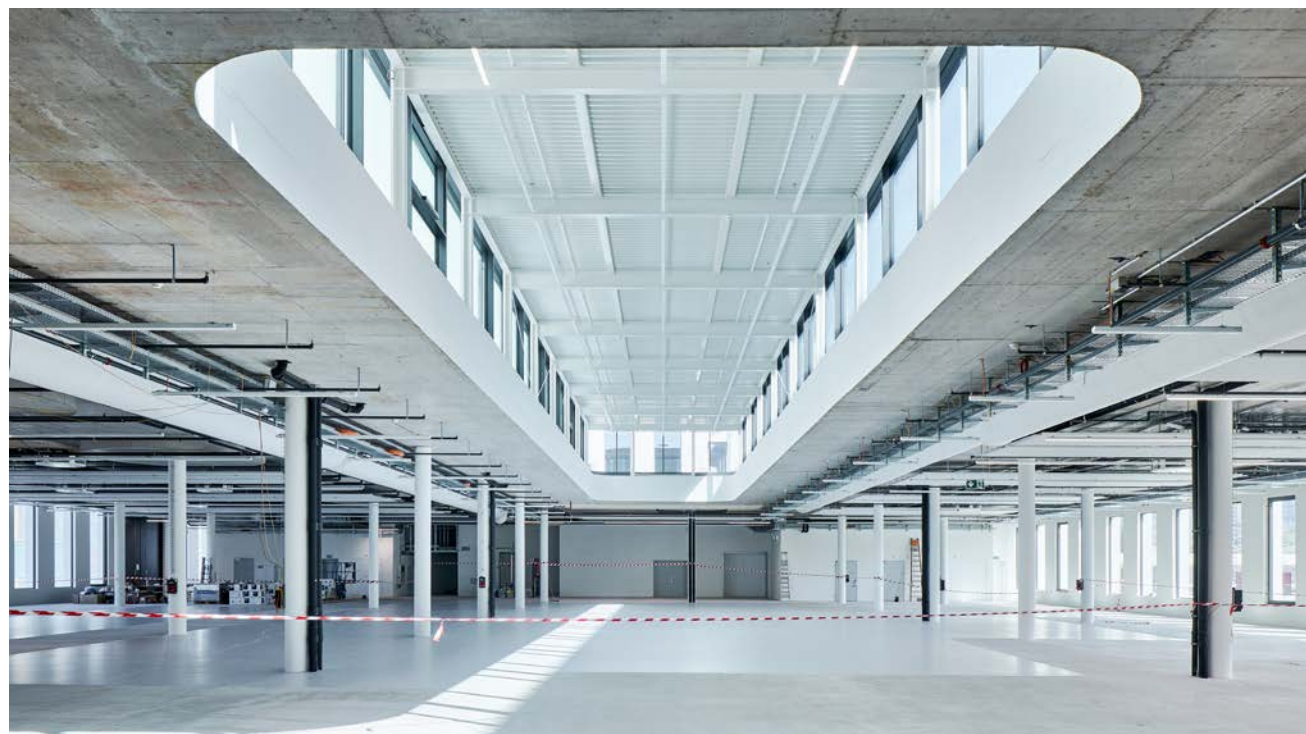
«Zephyr Ost»: Durch zahlreiche Massnahmen wurde der Betonverbrauch deutlich reduziert.
