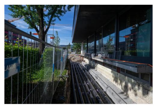
Ein leistungsfähiges 6-Leiter-Netz wird auf dem Areal des Tech Clusters Zugverlegt.
