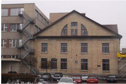
Abbildung 1.22: Magazinbau, Ansicht von Süden
