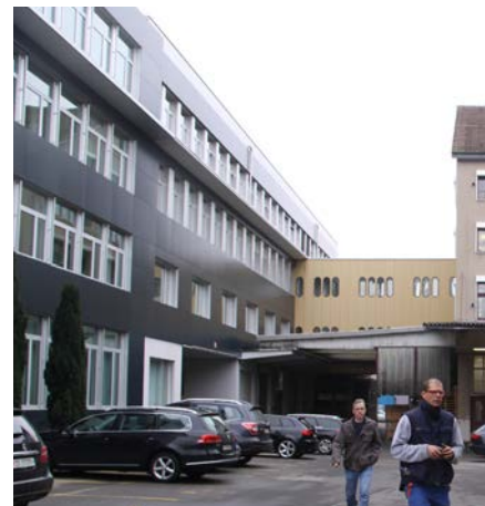
Abbildung 1.27: Verwaltungsbau Südfassade mit Brücke
