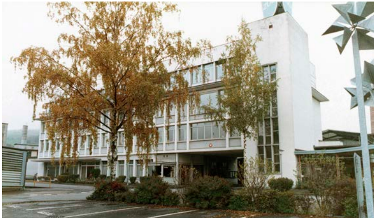
Abbildung 1.95: Verwaltungsbau Nordfassade Originalzustand
