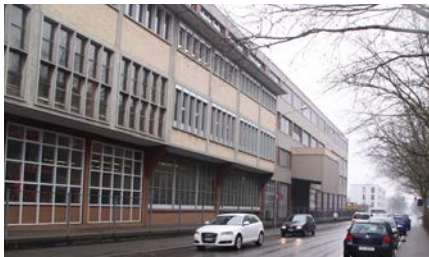
Abbildung 1.23: Industriestrasse Nord, Blick entlang der Industriestrasse nach Süden
